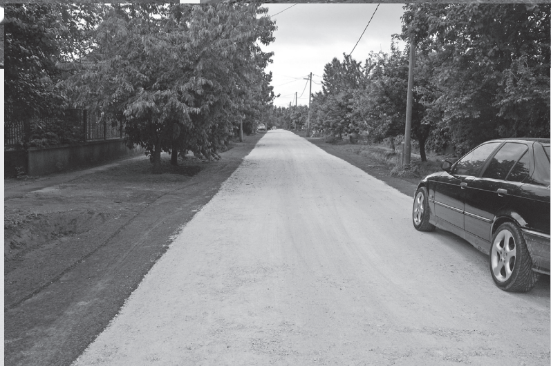
A Fürt út útalap építése
