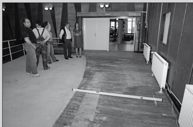
Burkolatfelújítás a Varsány Községi Házban
