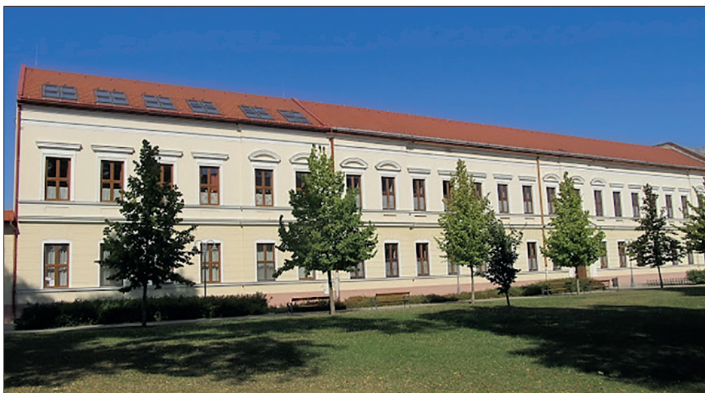
Az iskola épülete
